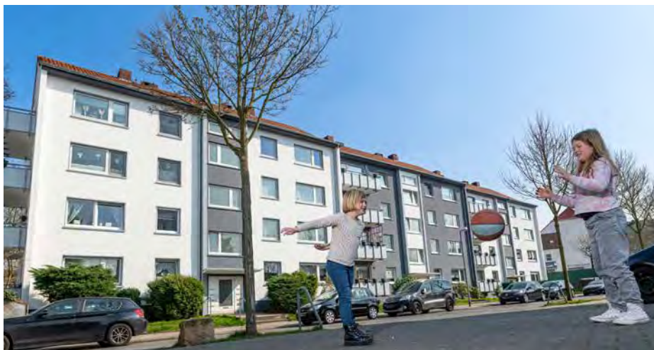
Mehrfamilienhäuser an der Weindorfstraße: ein Teil des „neuen“ Bestands in Gelsenkirchen-Rotthausen, wo die ggw ab 2022 ebenfalls für Stadt und Mieter am Ball ist
