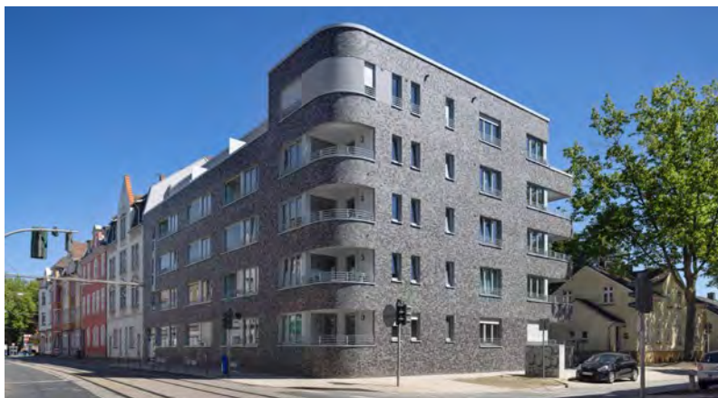
Die Architektur des neuen Gebäudes „Am Virchowbogen“ setzt mit dem geschwungenen Baukörper, kurzen Laubengängen und dem Staffelgeschoss reizvolle Akzente im Umfeld.
